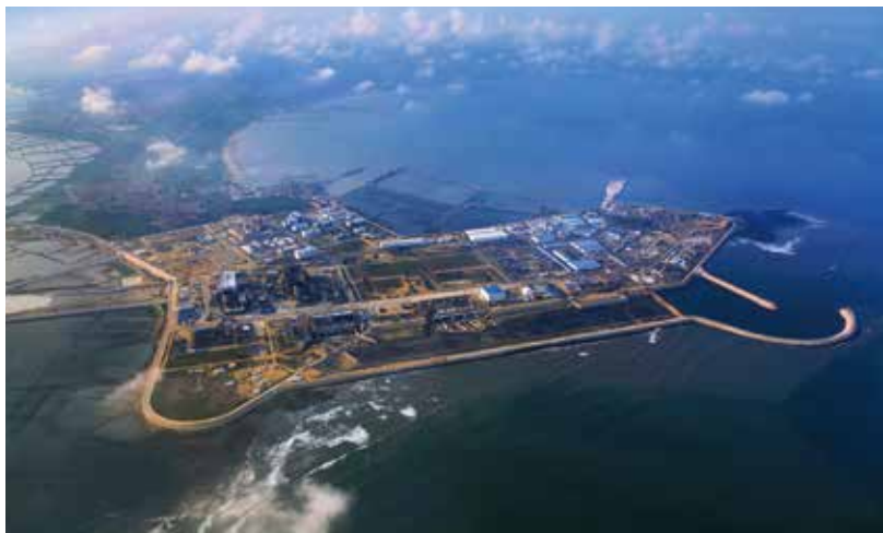
山东海阳核电项目航拍图。
