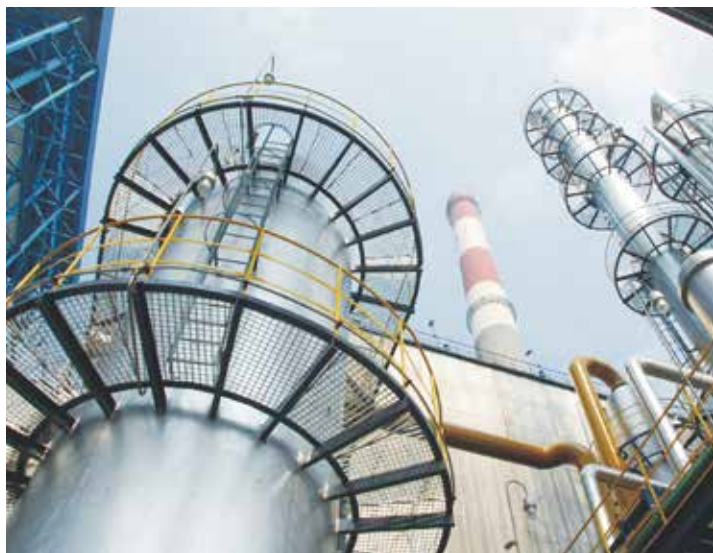
▲ 原烟气综合实验基地和年捕捉 1 万吨 CO 2 的碳捕集装置。
