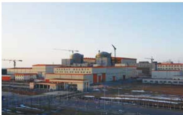
红沿河核电项目1、2号机组整体侧景。
