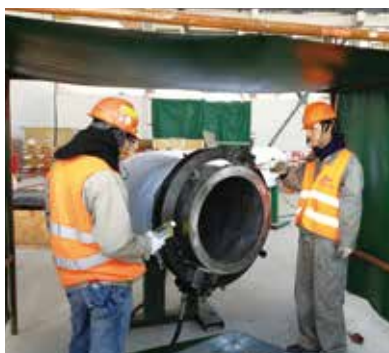
12月31日，1号核岛主管道施工开始。
