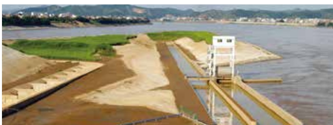
长洲水利枢纽工程鱼道。
