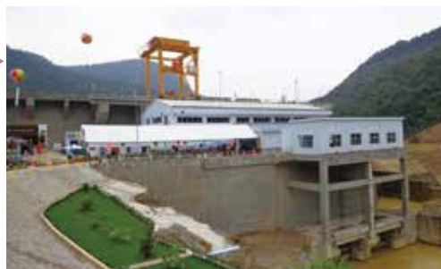
越南松泉六两台 1.45 万千瓦水电项目设备安装工程。
